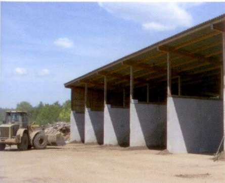
Lagerhalle für Kompost- und Erdenmischung
