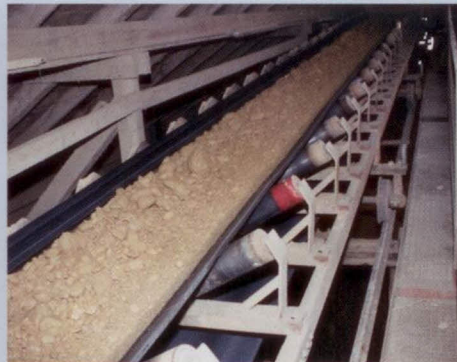
Rohkies aus der über 2 km entfernten Kiesgrube
