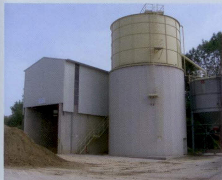
Wasserrückgewinnung und Filterpresse
