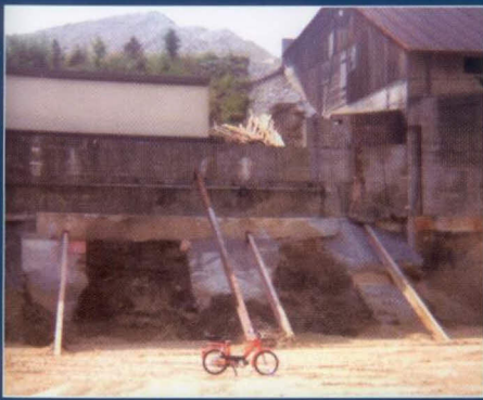
Abriss der alten Lkw-Halle 1976
