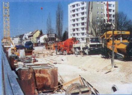
Das Betonieren von Bohrpfehlen ermöglicht den späteren Baugrubenaushub.
